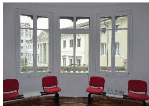
Palazzo vincolato dalle Belle Arti Sede INPS - Udine
